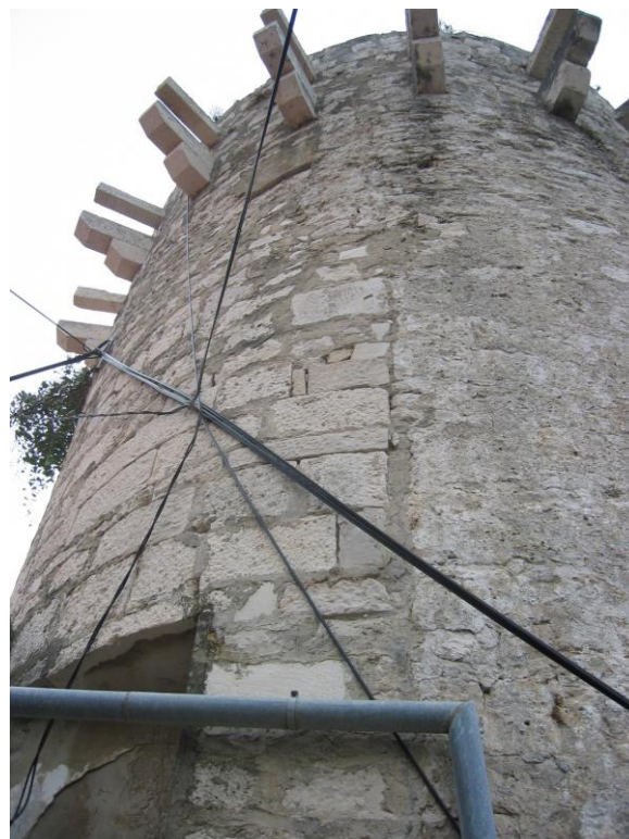
Sjeveroistočni dio kule sa zazidanim otvorom
