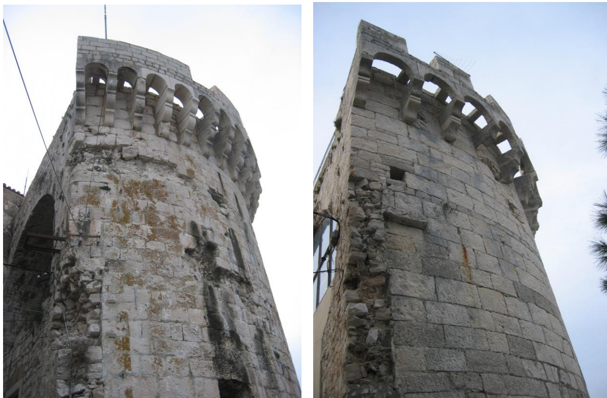
Korčula, kule Bokar i Berim, mašikul s kruništem, detalj gornjih i donjih konzola u odnosu na parapet
