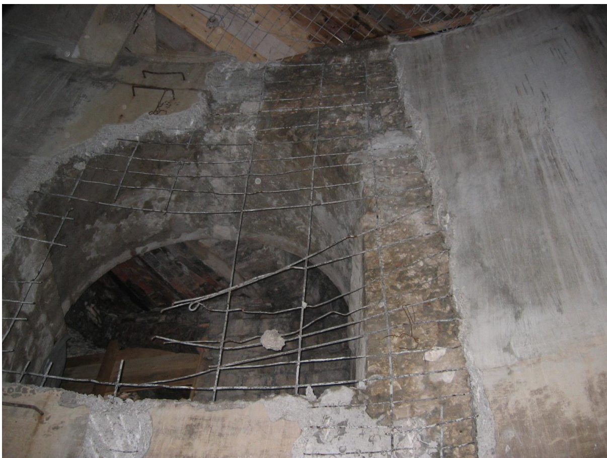
Uklanjanjem dijela betonskog plašta betona na mjestu ulaza u kulu
