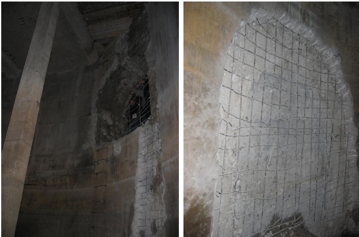
Unutrašnjost Velike kule nakon provedenih radova sondiranja debljine betonskog plašta
