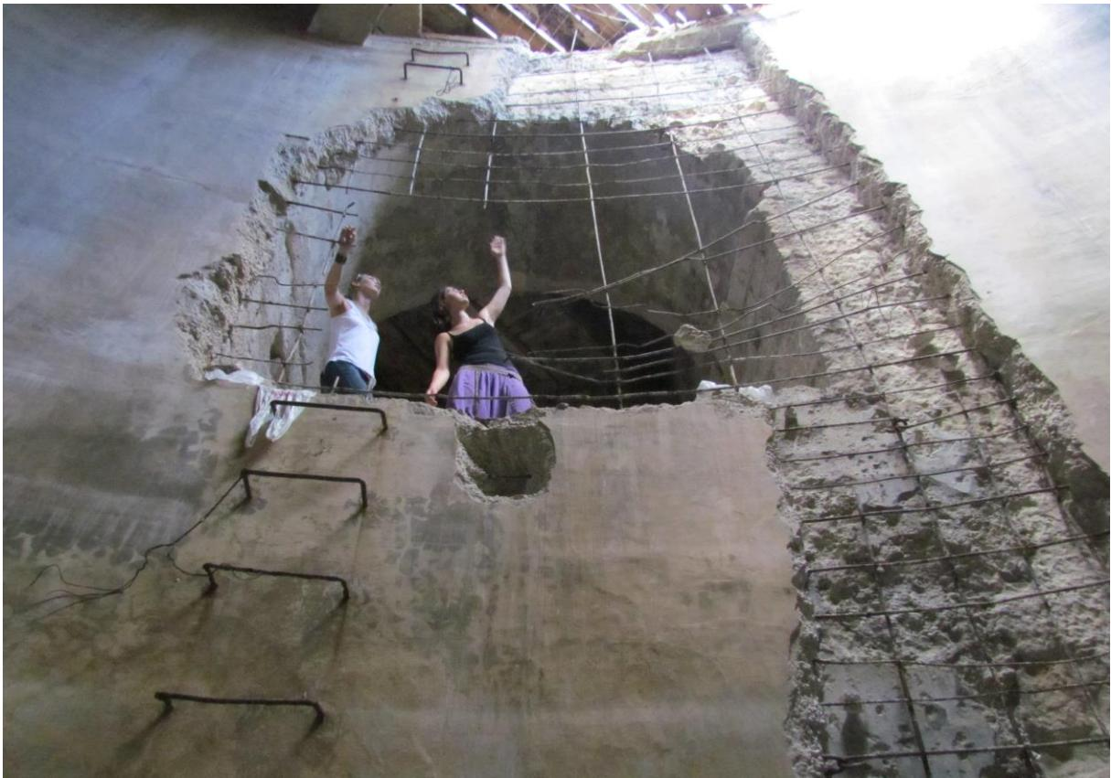
*Ulaz u kulu, desno sondirani armirano betonski plašt (foto Goran Nikšić)*
