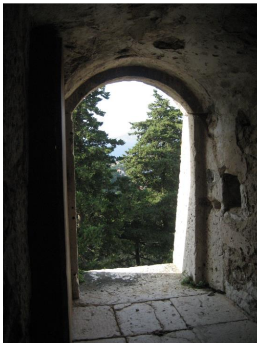
Unutrašnjost glavnog ulaza
