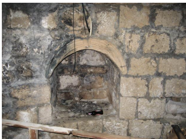
Niša u zidu na prvom katu
