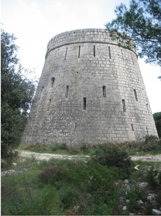
Pogled na kulu sa zapadne strane
