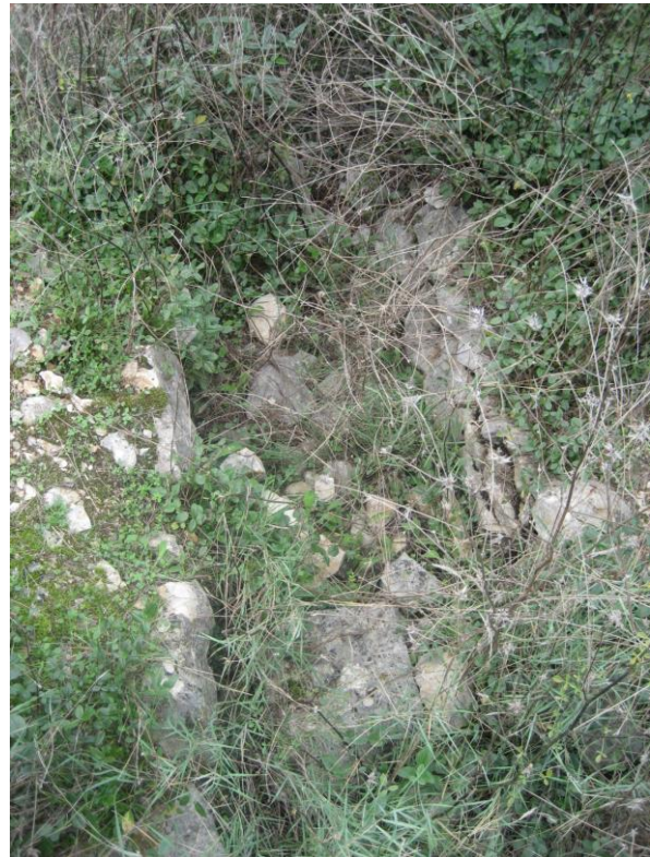
Kanal u sjeveroistočnom zidu (Izlaz za nuždu?)
