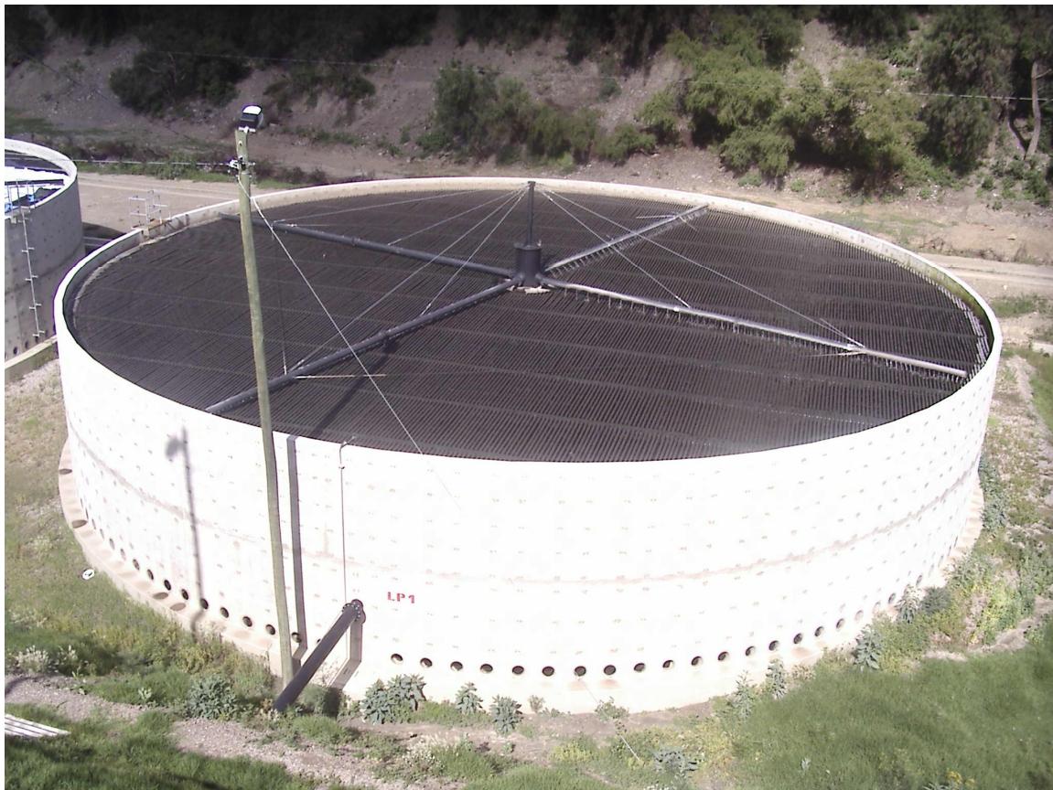
Slika 16: postrojenje s biološkim prokapnikom s ispunom Sessil ( Sucre /Bolivien)
