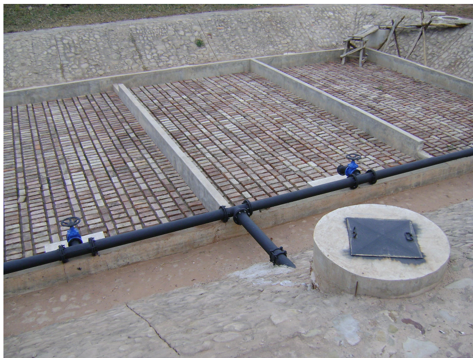
Slika 21: polja za sušenje nataloženog mulja
