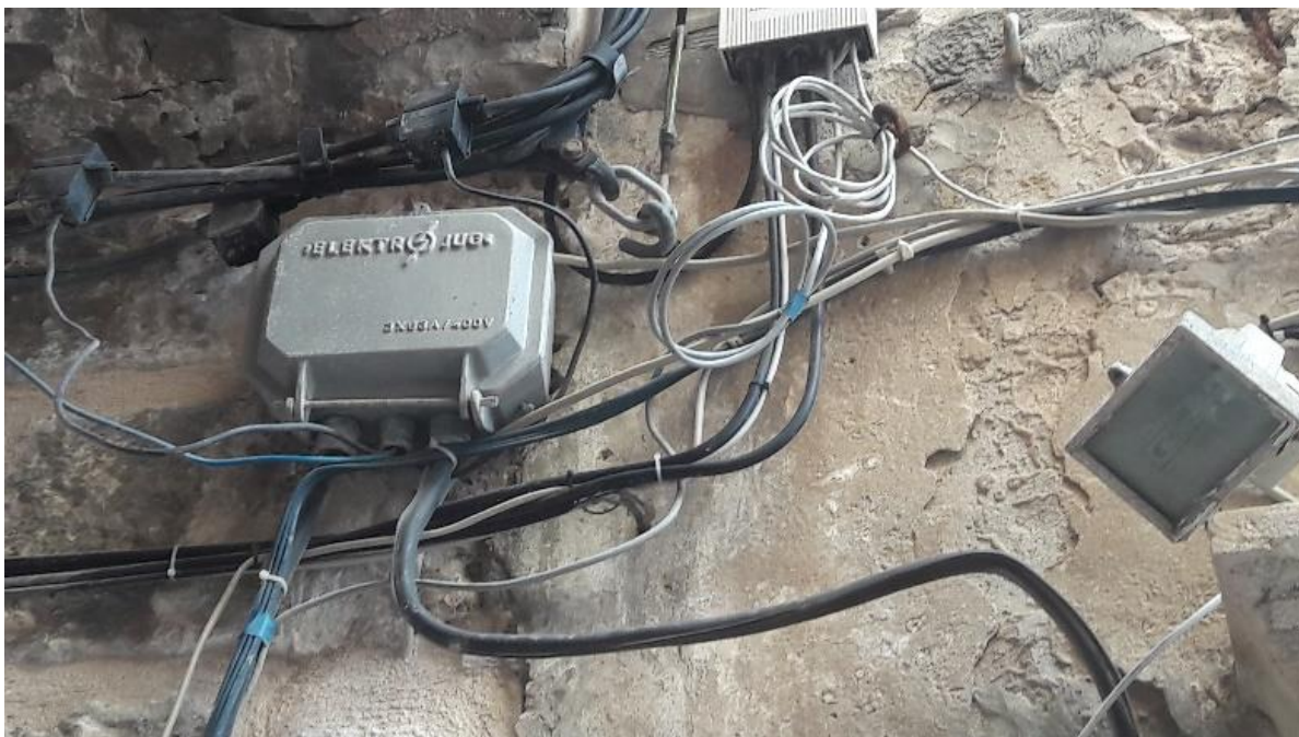
Sl. 43. Neadekvatno postavljene kablove elektroenergetske mreže
